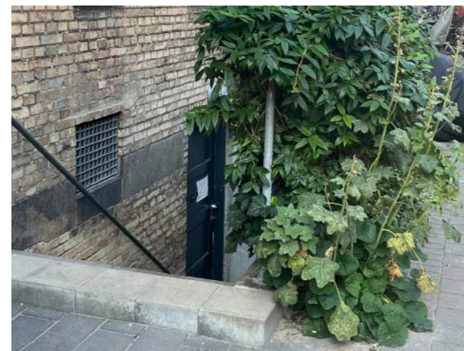
Skybrudssikring af trappenedgange
