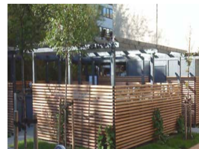
Pergola som let konstruktion
