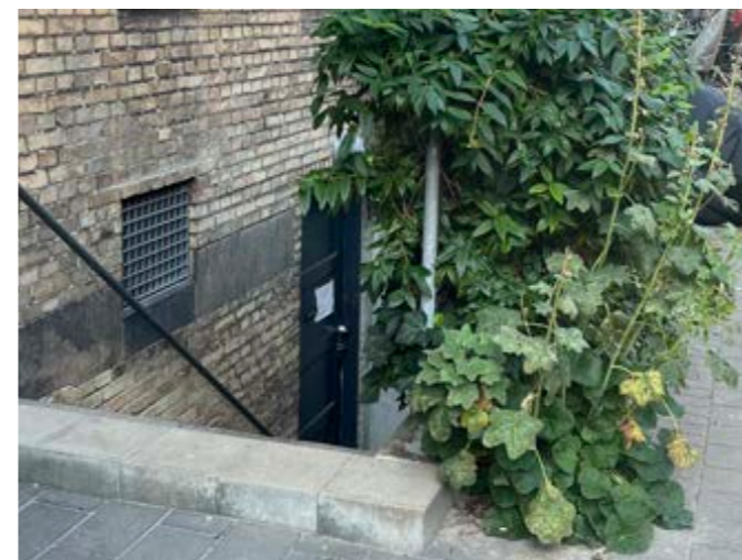
Skybrudssikring af trappenedgange
