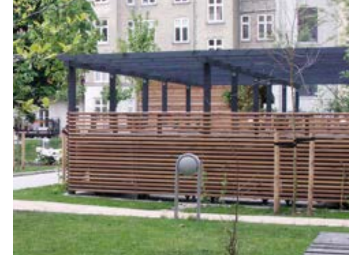
Pergola som let konstruktion
